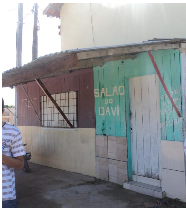
Fotografia 31 – Serviço construído ao lado das habitações
