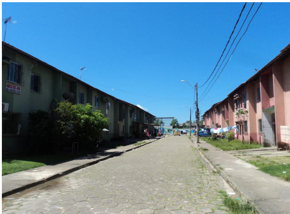
Fotografia 15 - Rua e calçadas do Projeto Taboquinha
