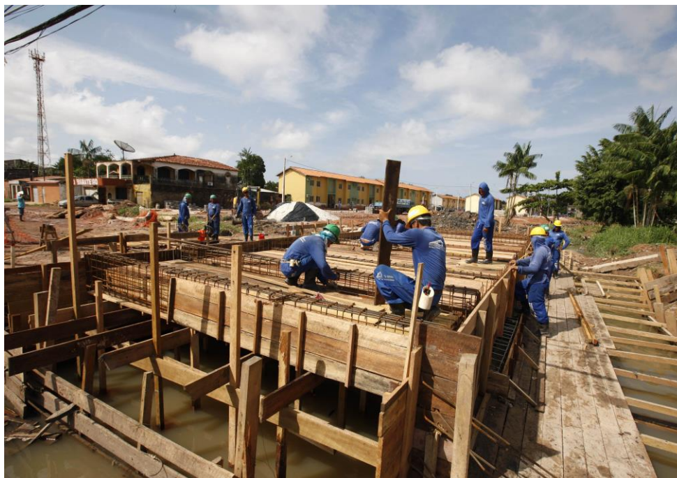
Fotografia 9 - Projeto Taboquinha em período de obras.
