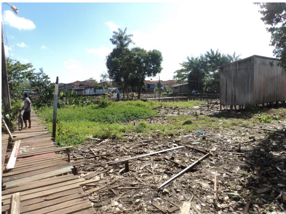
Fotografia 18 - Comunidade Cubatão com várias palafitas derrubadas
