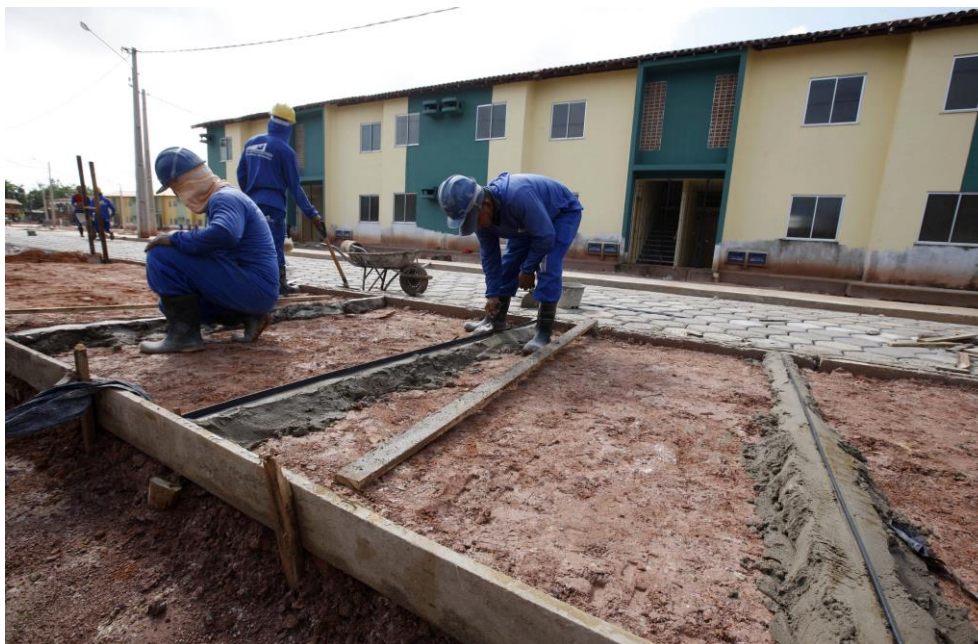
Fotografia 8 - Projeto Taboquinha em período de obras.
